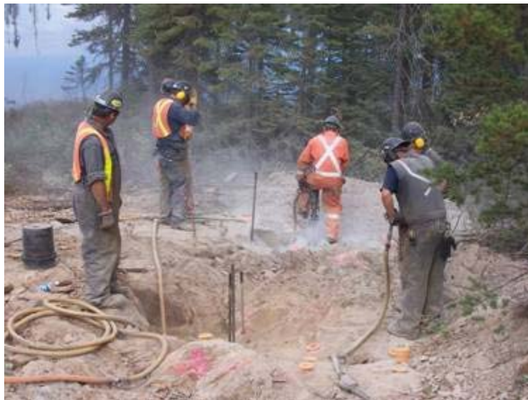
Photo des travailleurs préparant le dynamitage du site de décapage numéro 1.
